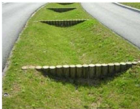
Figure 6 – Ouvrage de surface : noue d'infiltration
